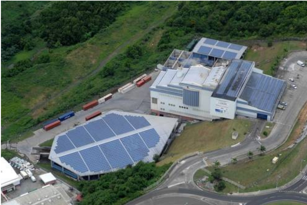
Figure 4.4 Usine d'incinération des ordures ménagères (UIOM) de Fort-de-France (tiré de : CACEM, 2013)
